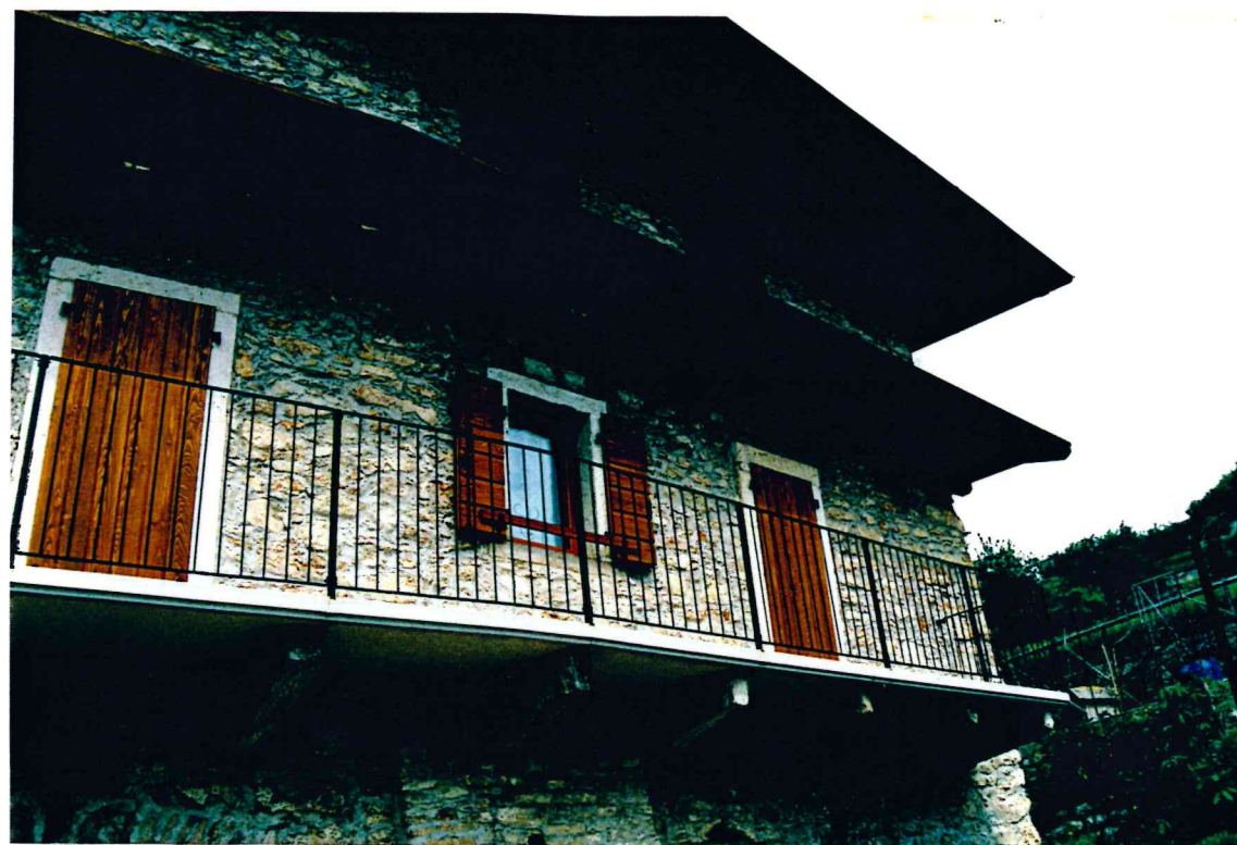
Particolare parapetto con elementi verticali con sezione mista, circolare all'estremità e quadrata nella parte centrale.
